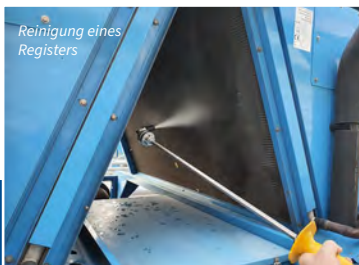
Reinigung von Wärmetauschern in einem Rechenzentrum mittels JetBoy
